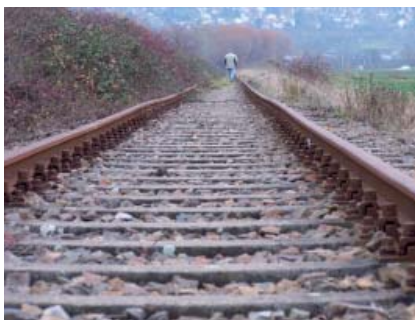
Beispiel für den Sanierungsbedarf: Gleisabsenkung und Bahnübergang
