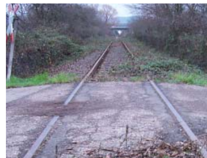
Beispiel für den Sanierungsbedarf: Gleisabsenkung und Bahnübergang
