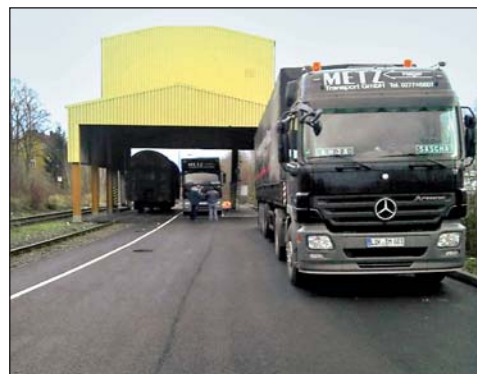
Abb. 5: Verladestelle Haiger mit sanierter Infrastruktur.
