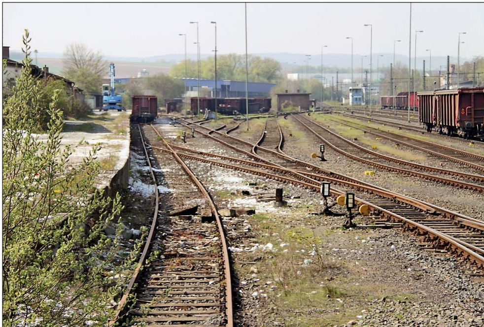
Abb. 6: Sanierungsbedarf beim neuen Gleisanschluss in Limburg.
