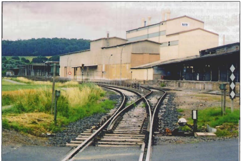
Abb. 3: Gleisanschluss der Firma RHI
