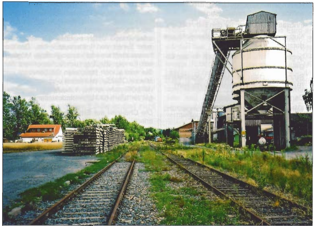
Abb. 18: Verladestelle der Firma OHI in Groß-Bieberau
