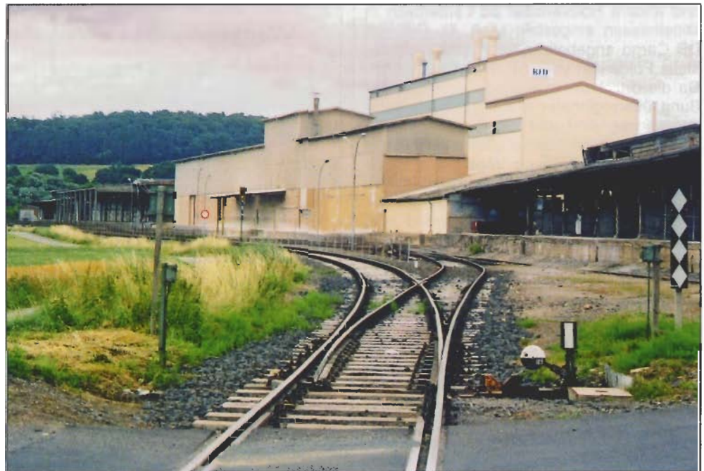
Abb. 3: Gleisanschluss der Firma RHI
