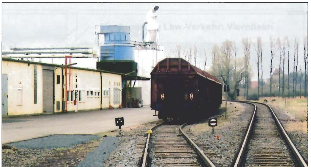
Abb. 16: Gleisanschluss der Firma Gebhardt (jetzt Firma Industriepark Nieder-Ofleiden)
