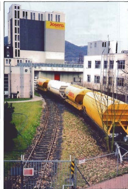
Abb. 12: Gleisanschluss der Firma Josera
