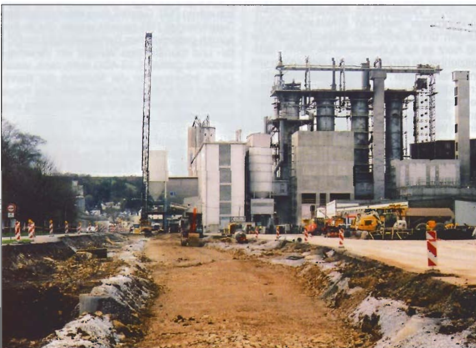
Abb. 20: Baumaßnahmen am Gleisanschluss der Firma Schaefer Kalk
