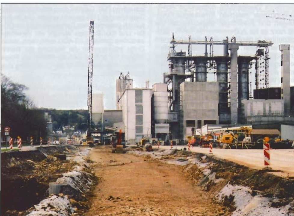
Abb. 20: Baumaßnahmen am Gleisanschluss der Firma Schaefer Kalk
