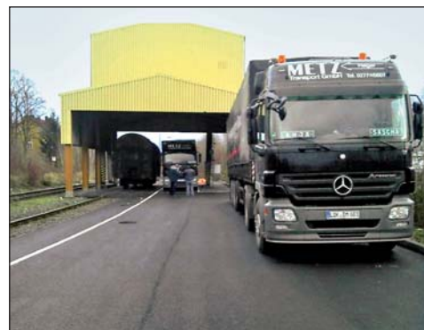
Abb. 5: Verladestelle Haiger mit sanierter Infrastruktur.
