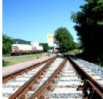
neuer Gleisanschluss: Platz für 25 Waggons
